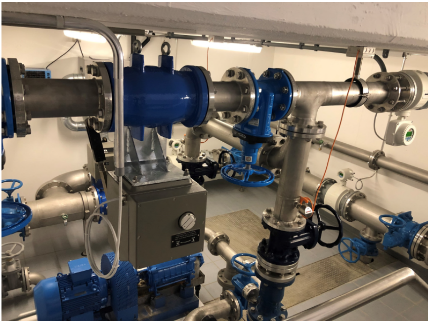
Sanierung Reservoir Buch
